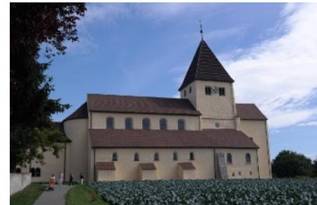
Abb. oben: von außen ablesbare **Geschossgliederung** durch **Seiten- und Mittelschiff** an der **Basilika St. Georg**, Oberzell, Reichenau (Frühmittelalter, vgl. S. 1)
