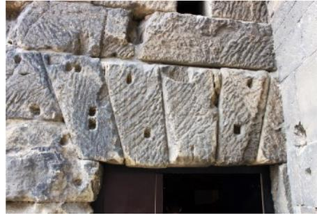
Abb. oben: **Scheitrechter Bogen** anstelle eines **Türsturzes** im Dom zu Trier (spätantik). Statt aufzuliegen zwängen sich die keilförmigen Steine zwischen die Mauerteile.
